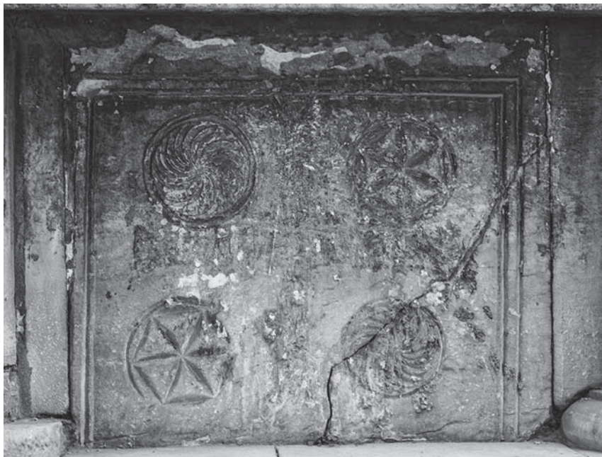
Fig. 1a - Vefa Kilise Camii, esterno, lato nord della facciata dell'esonartece, lastra centrale.
