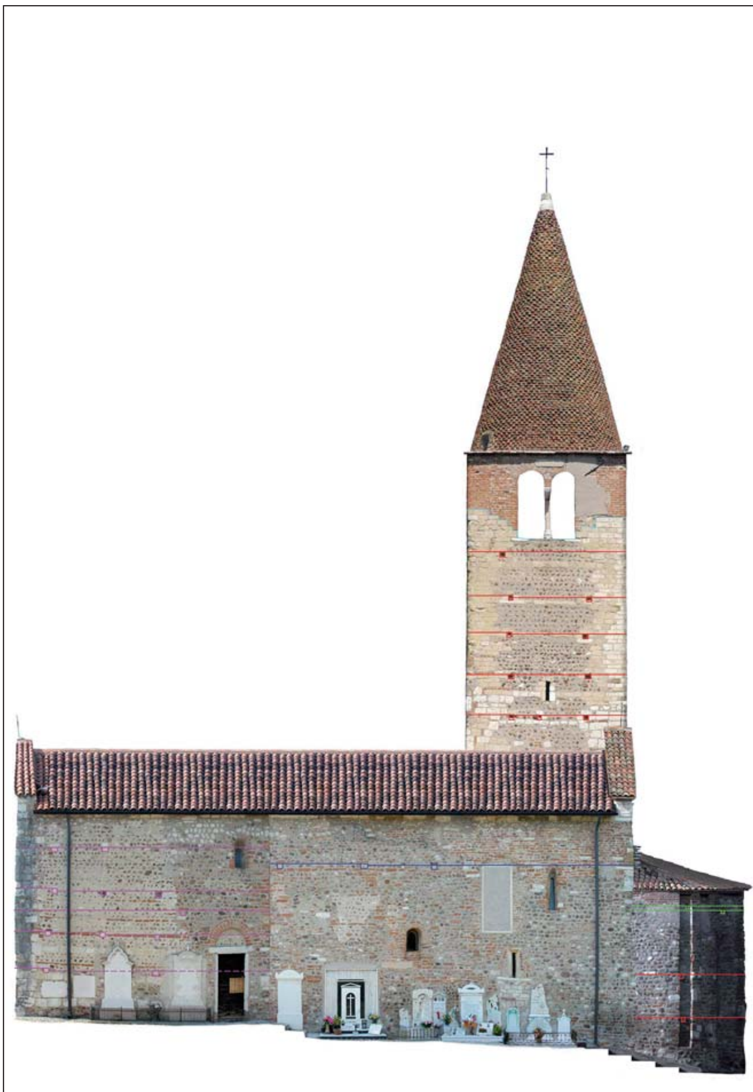
Fig. 13 - Palazzolo, Santa Giustina, prospetto sud.
