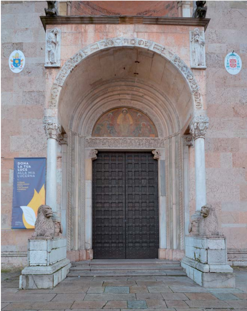
Fig. 2 - Piacenza, facciata della cattedrale, portale principale e protiro.
